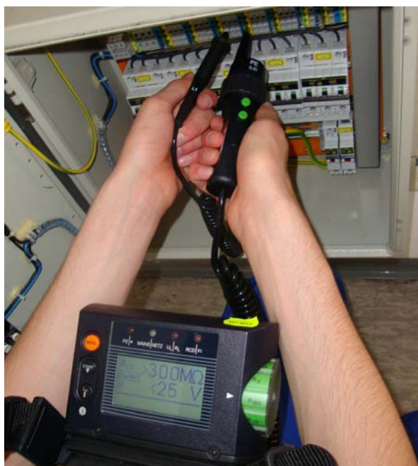
Abb. 1 1) : Wiederholungsprüfung an einer elektr. Anlage
